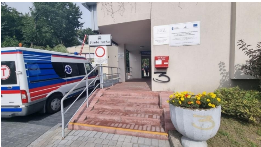
Zdjęcie nr 4: Tylne wejście - przy bramie wjazdowej
